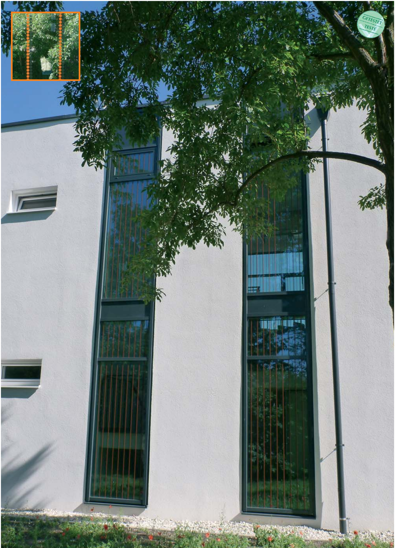
Einige der im Flugkanal als hoch wirksam getesteten Muster werden inzwischen schon werkseitig zum Aufdruck auf das Glas angeboten und müssen nicht erst nachträglich als Folienlösung appliziert werden.
