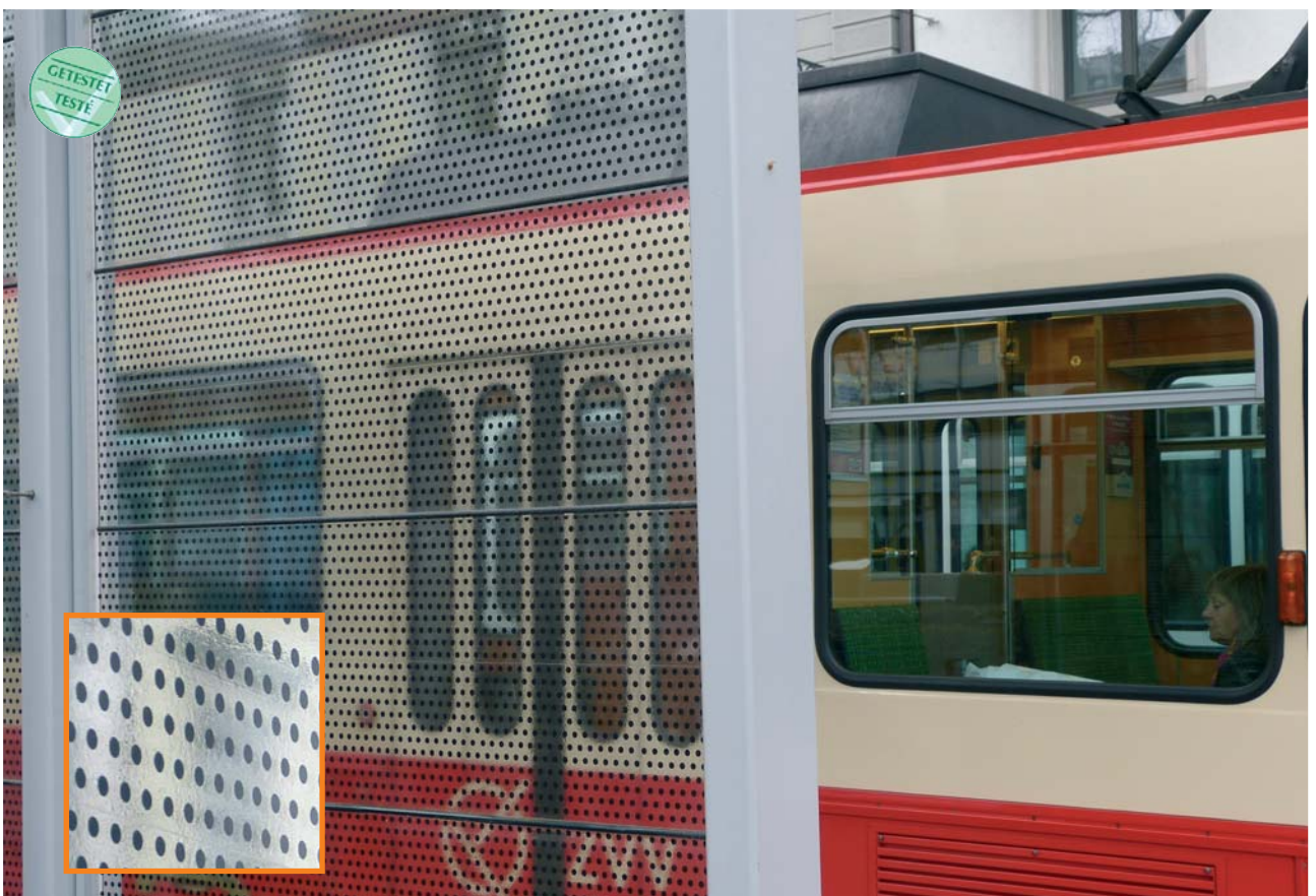
Diese Tramhaltestelle wurde mit einem schwarzen Punktraster versehen. Die Durchsicht ist gewährleistet, das Muster wirkt unaufdringlich.
