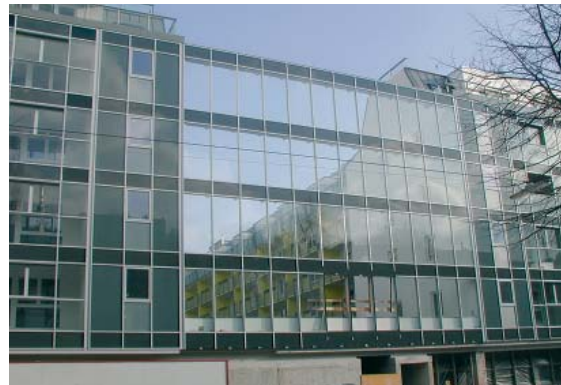
Wind- und Lärmschutz zwischen Gebäuden
