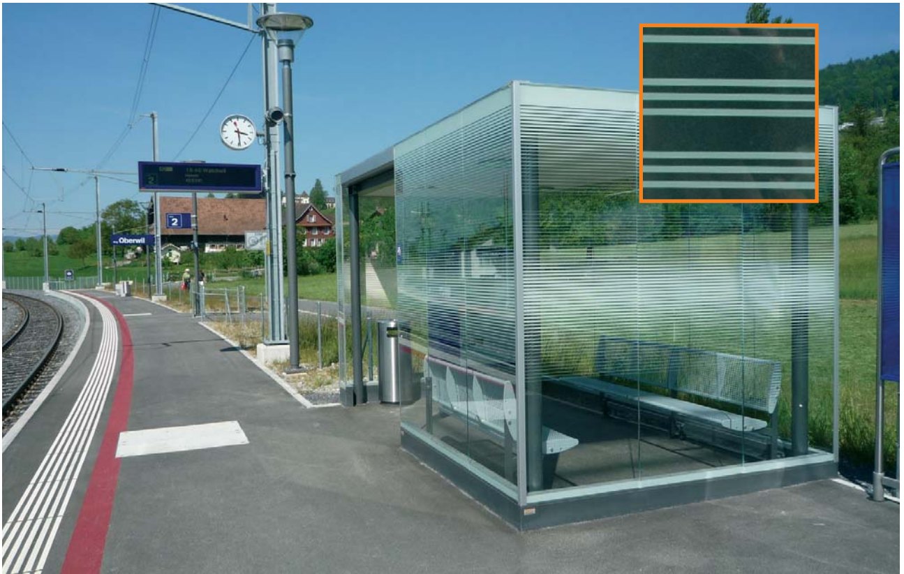
Neuer Standard für die Wartehäuschen der Schweizerischen Bundesbahnen. Im bodennahen Bereich hat man auf Markierungen verzichtet. Der Durchblick dort wird durch die Inneneinrichtung vermindert.
