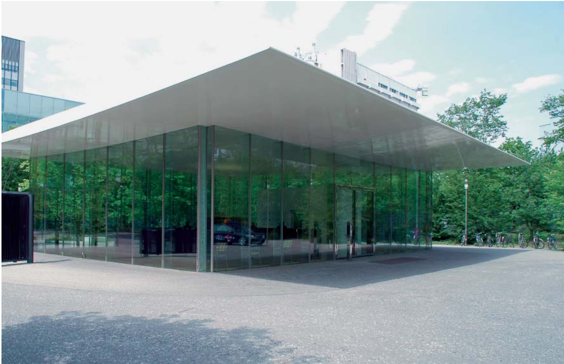
Empfangsgebäude eines grossen Industriebetriebes. Die optische Verknüpfung von Innen- und Aussenraum ist für Vögel höchst gefährlich. Ebenso tückisch sind Gebäude an Gewässern oder in Grünanlagen, wenn spiegelnde Fassadenteile einen Verbund mit der Umgebung schaffen.
