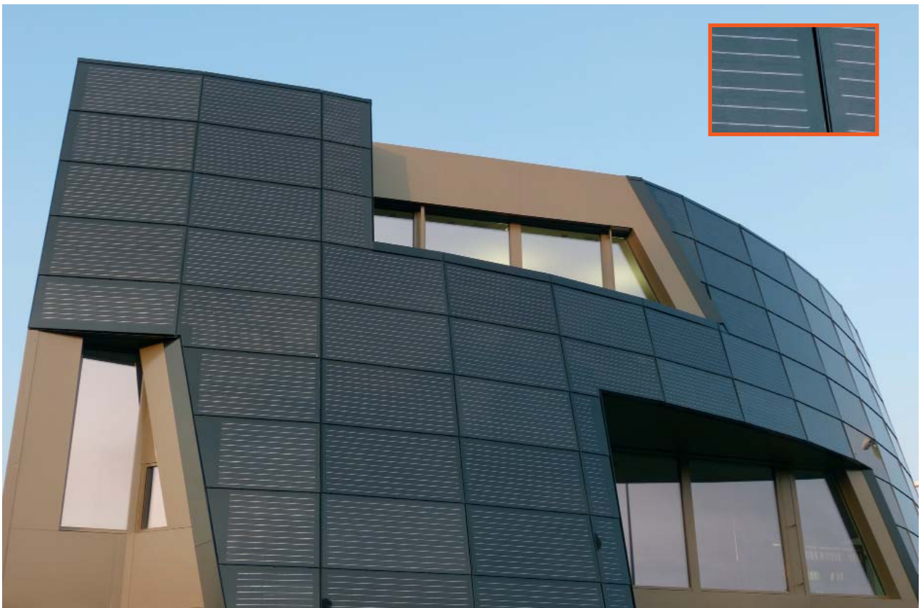
Innovative Architektur mit Solarpanels als Fassadenabdeckung. Diese spiegeln zwar etwas, weisen jedoch durch die Leiter auch eine gewisse Struktur auf und stellen für Vögel keine Gefahr dar.
