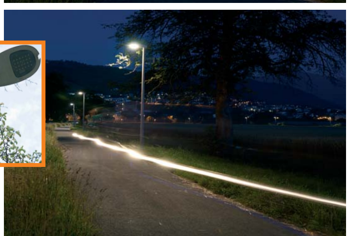
Ein Fuss- und Radweg, ausgerüstet mit neuesten Beleuchtungsmitteln, die mit Bewegungsmeldern gekoppelt sind. Erst wenn ein Radfahrer vorbeifährt, wird die minimale Beleuchtung hochgefahren.
