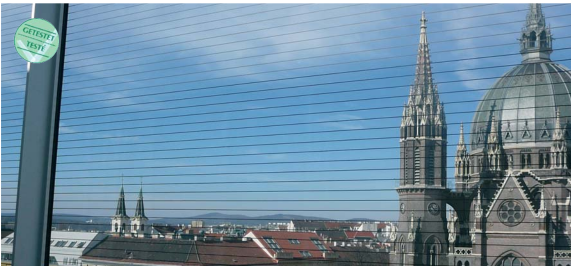
Schwarze, horizontale Linien von 2 mm Breite und einem Lichtmass von 28 mm schnitten in Flugtunnelversuchen wider Erwarten sehr gut ab. Wo es auf möglichst ungetrübte Durchsicht ankommt, ist das vor einem hellen Hintergrund ein gangbarer Kompromiss. Es wird allerdings empfohlen, die Linien mindestens 3 mm breit zu machen.
