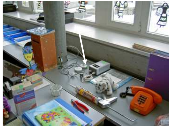
Abb. 4: CO 2 -Messung im Schulhaus Sarrenstorf
