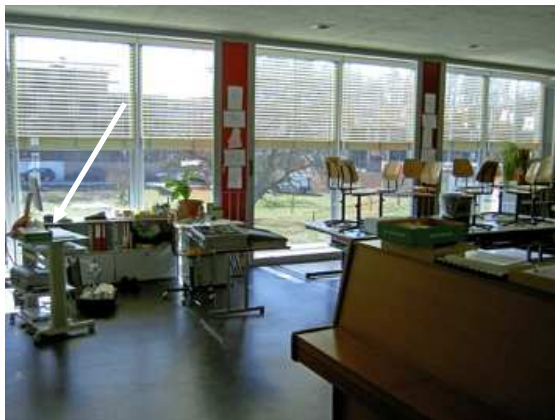
Abb. 11: CO 2 -Messung im Raum 16 (mech. Lüftung), Schulhaus Baden Dättwil
