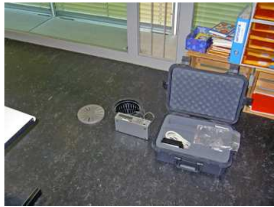
Abb. 12: Feinstaubmessung im Zuluftstrom, Schulhaus Baden Dättwil
